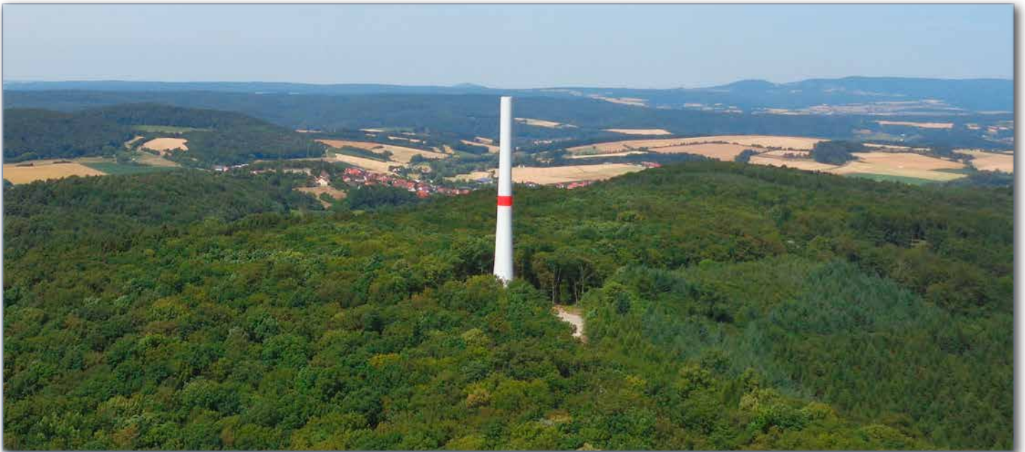
Blick vom Turm 1 zu Turm 2
