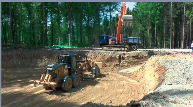
Fundamentsohle für das Windrad 1
