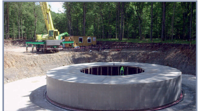
Fundamentsohle für das Windrad 2
